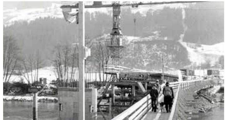
März 1984: Bau der neuen Piller Brücke mit Sicht von Vomperbach in Richtung Pill. Für die Fußgänger wurde während der Bauzeit ein behelfsmäßiger Fußsteg aus Holz errichtet.
